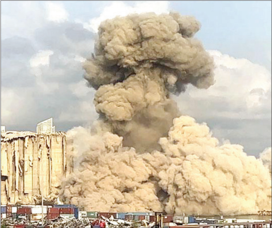
تخریب و ریزش سیلوهای فلات بندر بیروت لبنان/ آسویتدپرس
